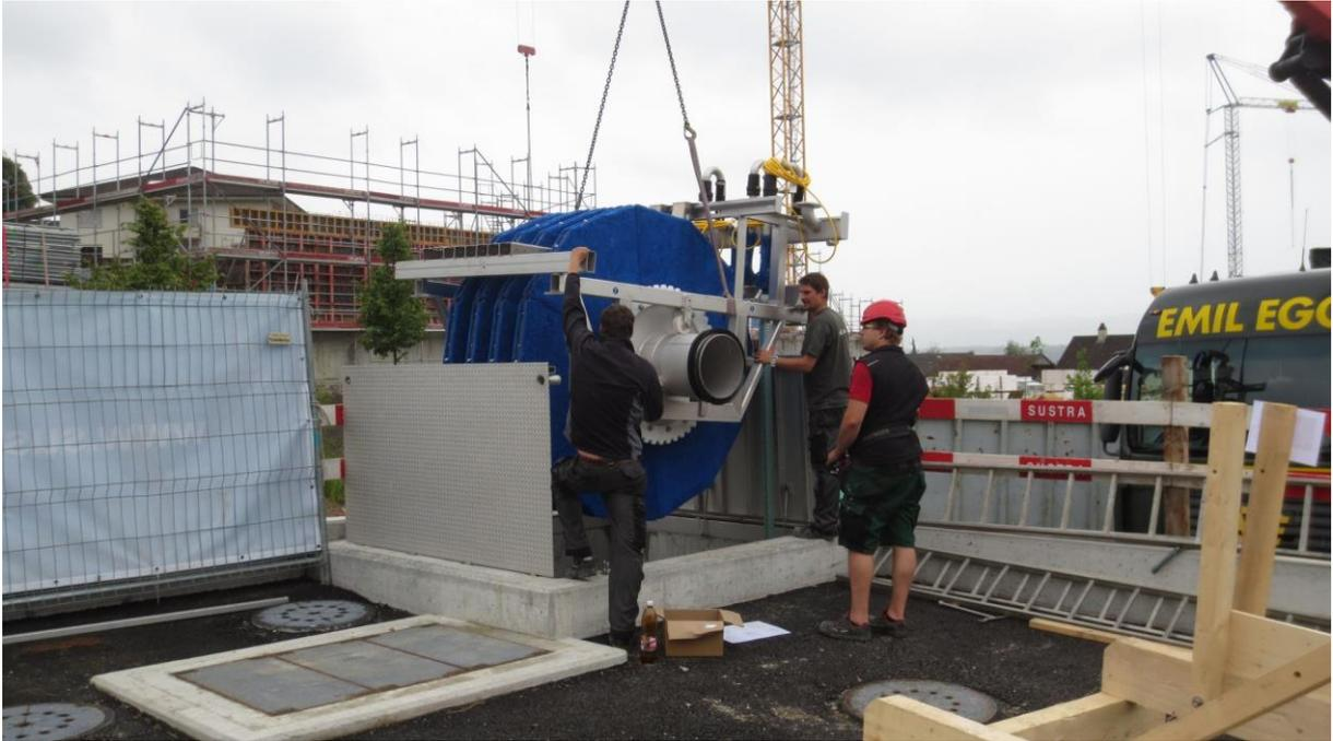
Abbildung 5: Einbau Scheibenfilter Technische SABA K 14 Büren
