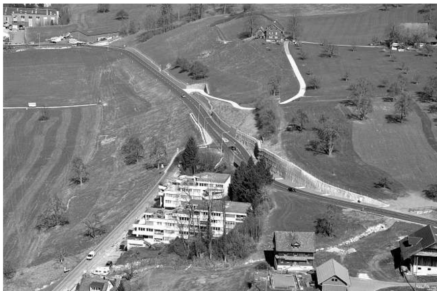
Götzentalsstrasse (Oberfeld bis Kandishof)
