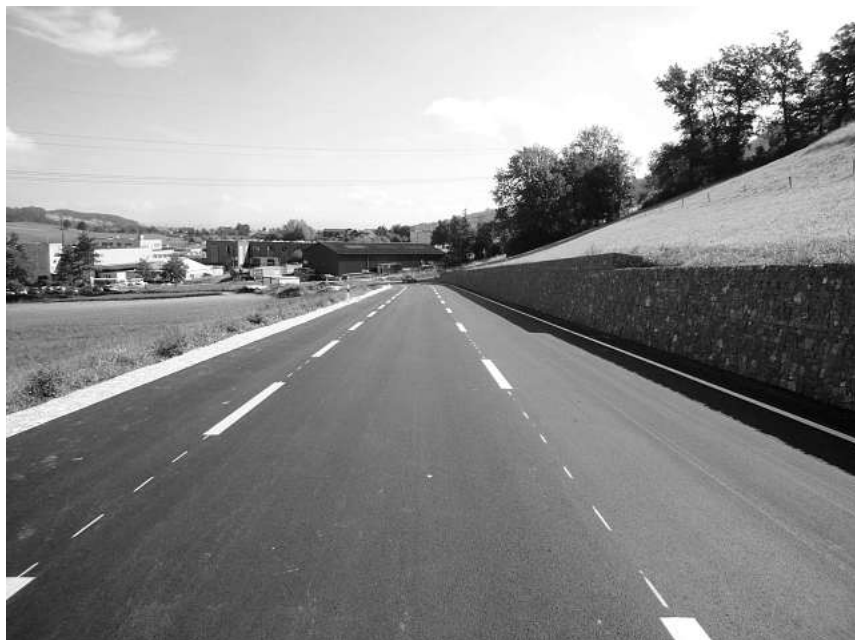
Götzentalstrasse (Radstreifen, Strasse, Hangsicherung mit Steinkörben)
