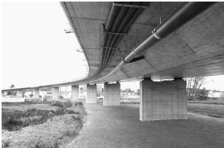
Neue Brücke über Gleise SBB
