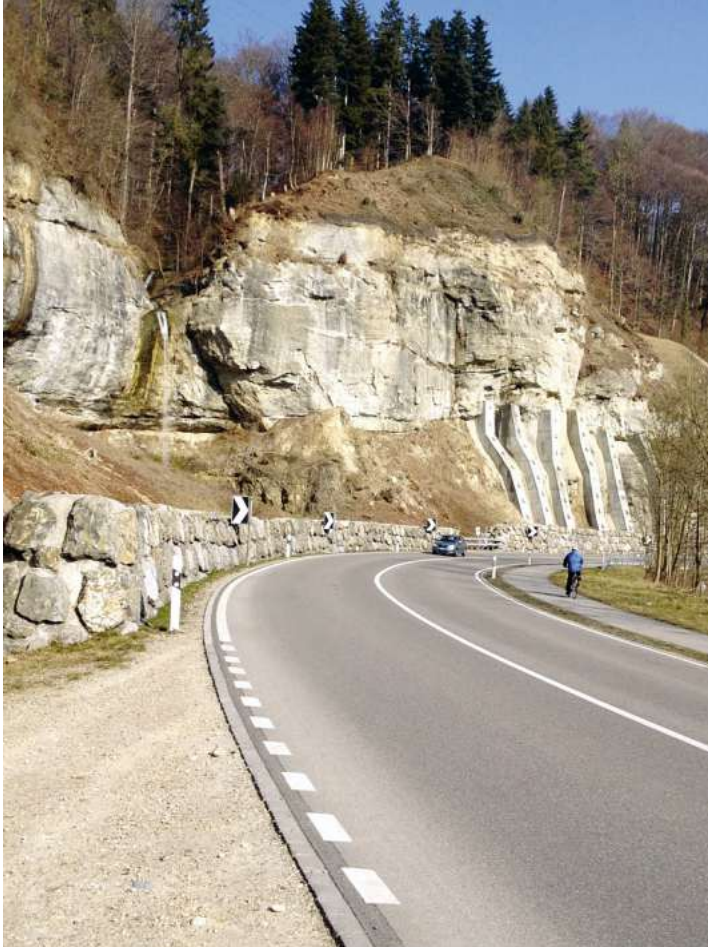
Wasserfallkurve (Schuttdamm, Strasse, Rad-/Gehweg)
