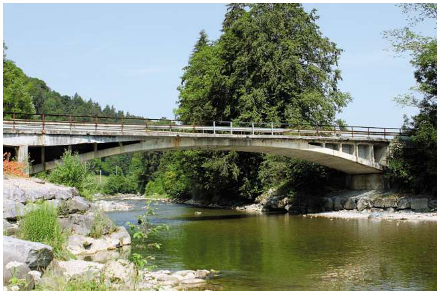
Foto Nr. 3: Langnauerbrücke, rechtes Ufer, Blickrichtung flussaufwärts
