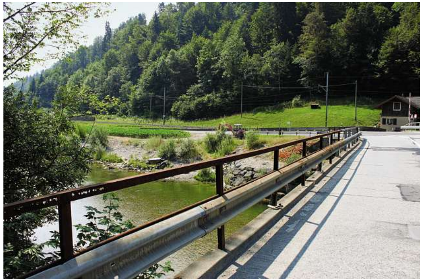
Foto Nr. 7: Blickrichtung Schachen mit rechtem Widerlagerbereich der neuen Brücke
