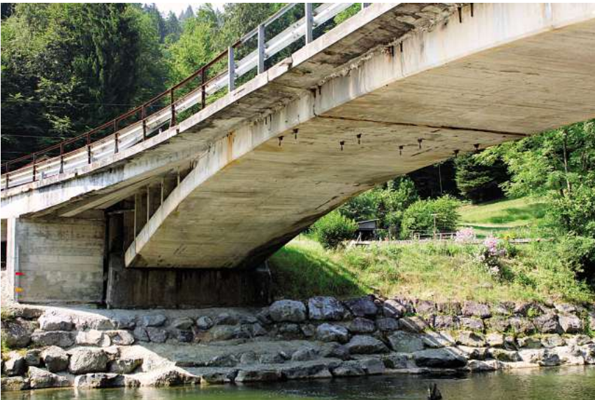
Foto Nr. 6: Langnauerbrücke, linkes Ufer, Blickrichtung flussaufwärts
