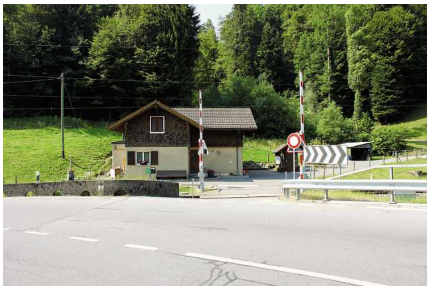
Foto Nr. 4: SBB-Bahnübergang
