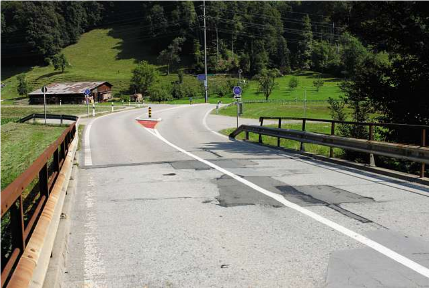
Foto Nr. 5: Brückenmitte, Blickrichtung Einfahrt Kantonsstrasse K10 mit Radwegquerung
