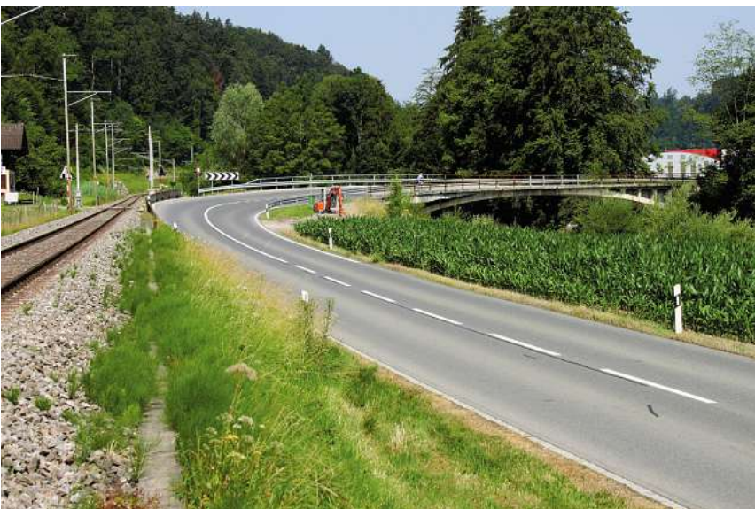
Foto Nr. 2: Bahnübergang und Langnauerbrücke aus Richtung Schachen
