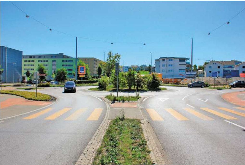
Foto Nr. 5: K18, Blickrichtung von Sursee, Ringstrasse Nord zum Kreisel Chotten
