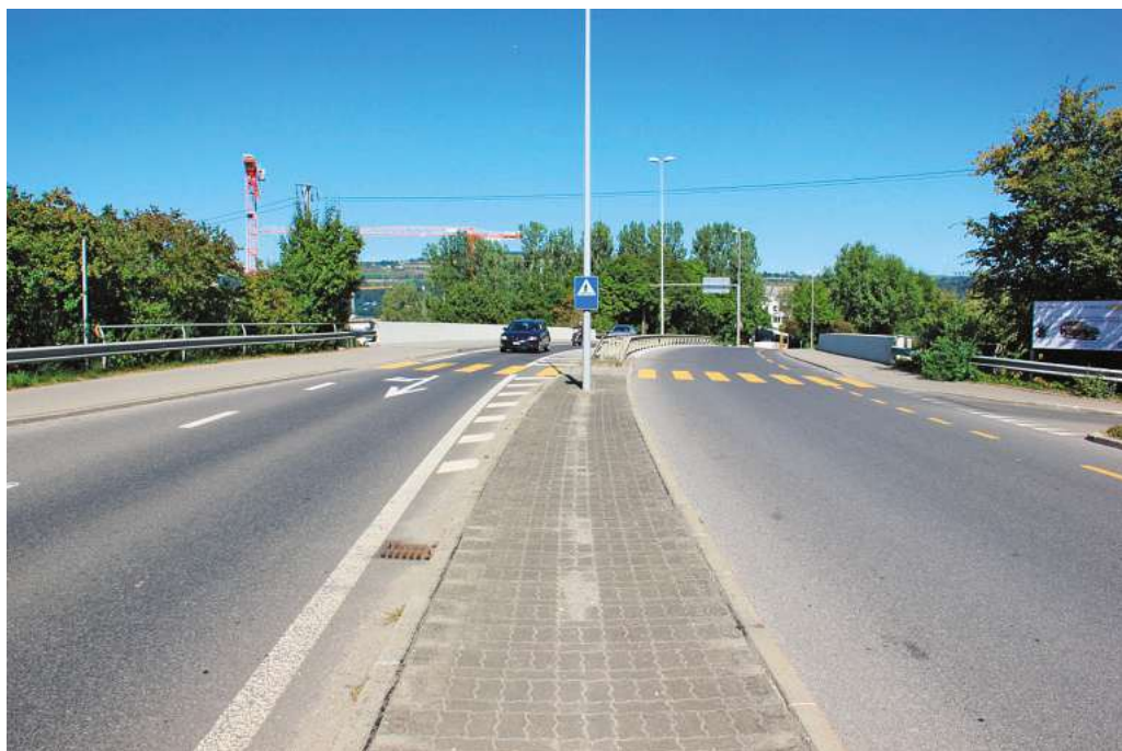
Foto Nr. 7: K18, Ringstrasse Nord, Blickrichtung vom Kreisel Chotten zur Chottenbrücke
