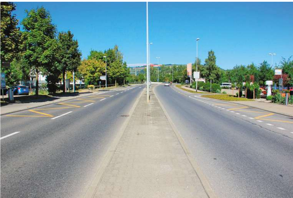
Foto Nr. 6: K18, Ringstrasse Nord, Blickrichtung vom Kreisel Chotten zur Chottenbrücke
