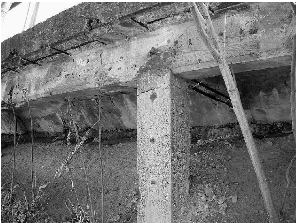
Foto Nr. 3 – Abschnitt Innerschachen, Erneuerungsbedarf Gehwegauskragung
