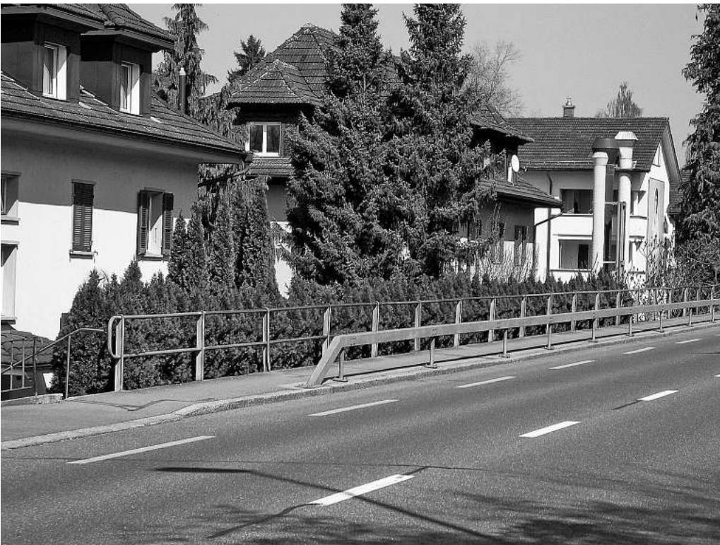
Foto Nr. 2 – Abschnitt Innerschachen, Gehwegauskragung
