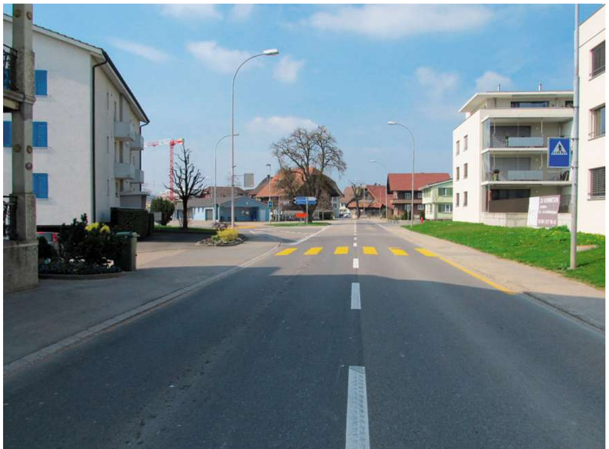
Foto 6: Grosswangerstrasse aus Fahrtrichtung Grosswangen vor Perimetergrenze
