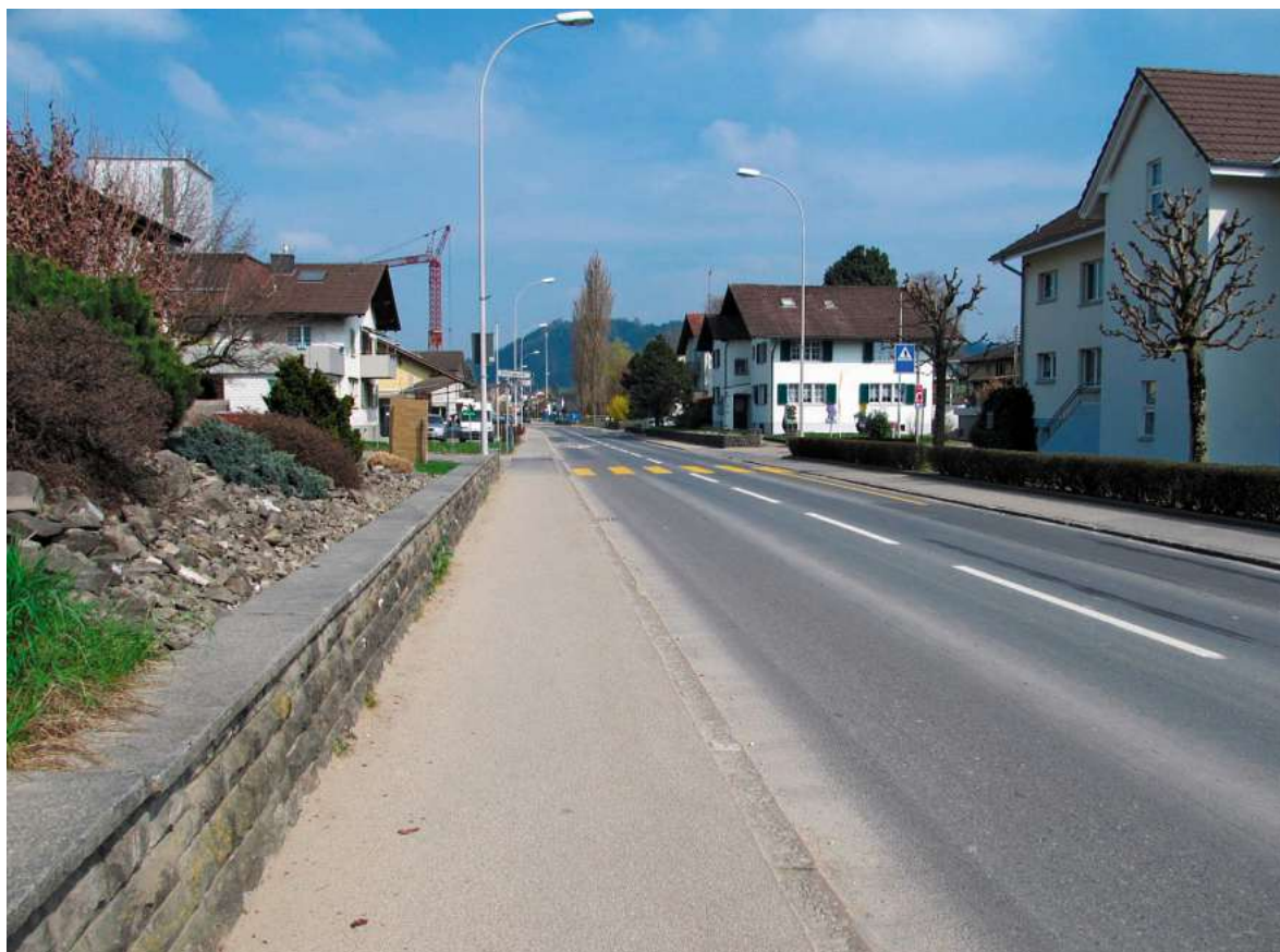
Foto 9: Surseestrasse im Bereich der neuen Stützmauer (links)
