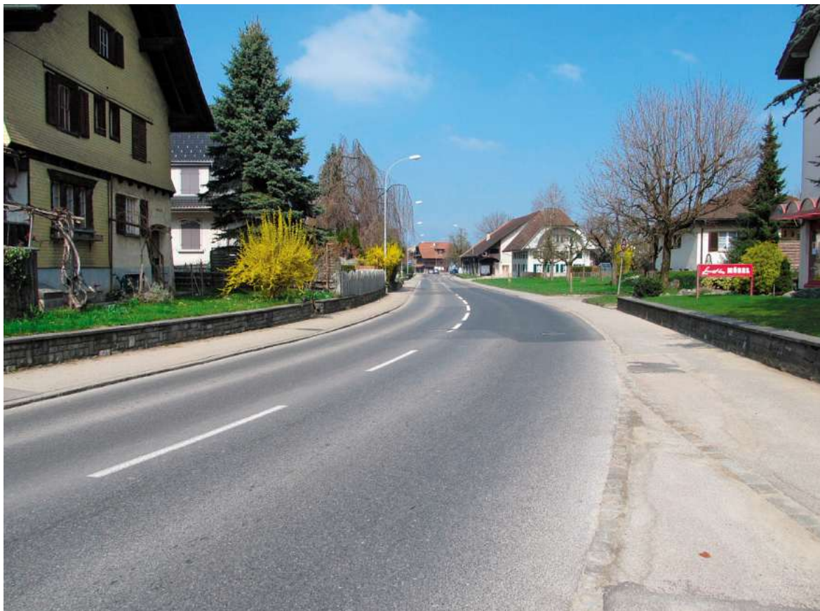
Foto 3: Willisauerstrasse bei Einmündung Bresteneggstrasse (Bereich mit neuer Lärmschutzwand auf der linken Strassen- seite)
