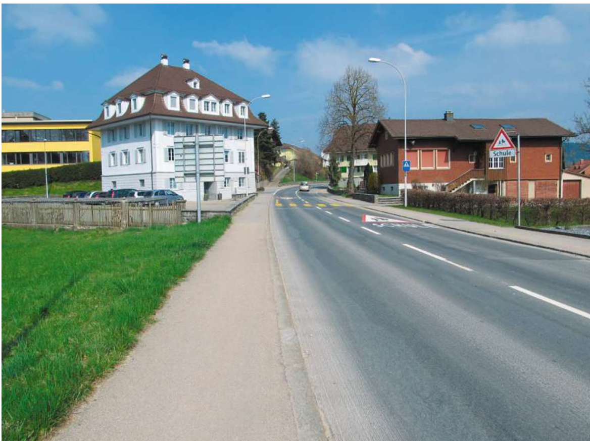
Foto 8: Surseestrasse in Fahrtrichtung Sursee vor Gemeindehaus (links)
