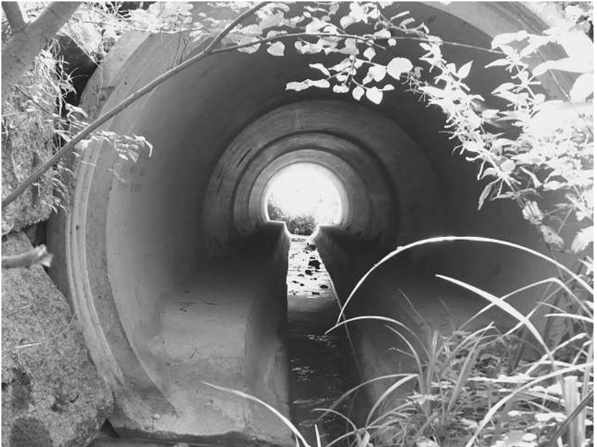
Bachdurchlass unter der K 10 mit Niederwasserrinne und seitlichen Bermen für Kleintiere
