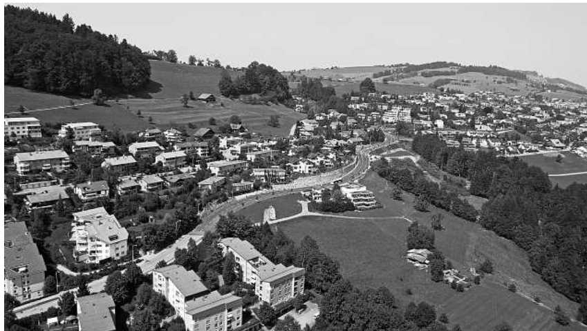
Das ausgebaute Teilstück der K30 im Überblick (Blick von der Stadtgrenze Richtung Adligenswil)
