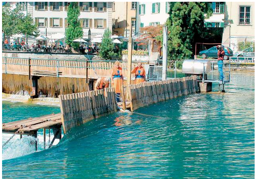
Schliessen des Stirnwehrs von Hand
