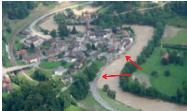
Bild 2: Ufererosion bei Werthenstein
