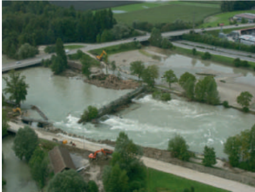
Bild 13 Reussbrücke, Querdamm sowie Wehr Perlen nach dem Hochwasser vom 22. August 2005
