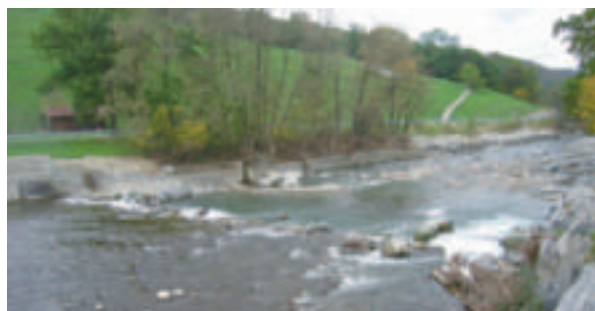
Bild 5: Zerstörte Schwelle bei Malters
