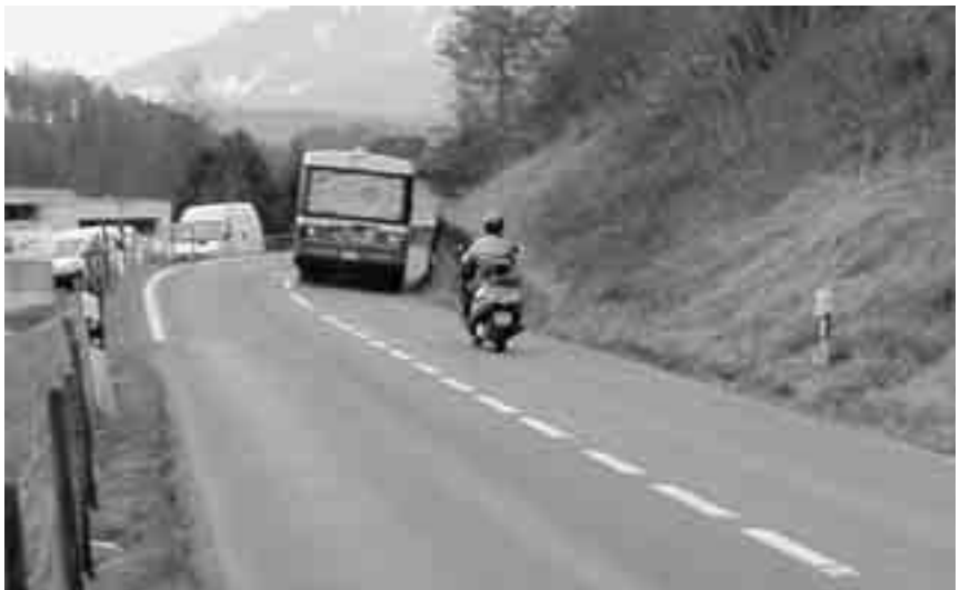
Blickrichtung Luzern: schmale Fahrbahn, unübersichtliche Kurve, keine Fussgänger- und Radverkehrsanlagen
