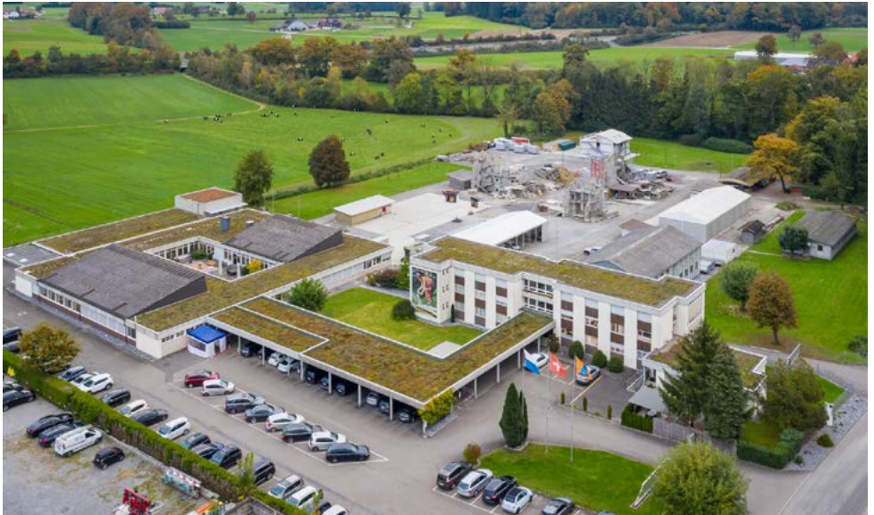
Heutige Situation (links: Instruktionsgebäude mit Innenhof, rechts: Verwaltungsgebäude, Mitte: Verbindungsdach (Luftaufnahme 2020))
