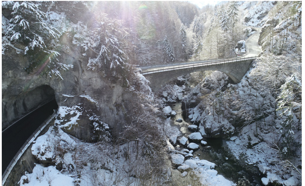
Chlusstaldentunnel mit Chlusbodenbrücke. Fast jährlich ereignen sich grössere Stein- und Blockschläge sowie Sturmschäden. Die Kantonsstrasse K 36 soll daher erneuert, ausgebaut und mit zusätzlichen Vorkehrungen geschützt werden. (Bild: BUWD)
