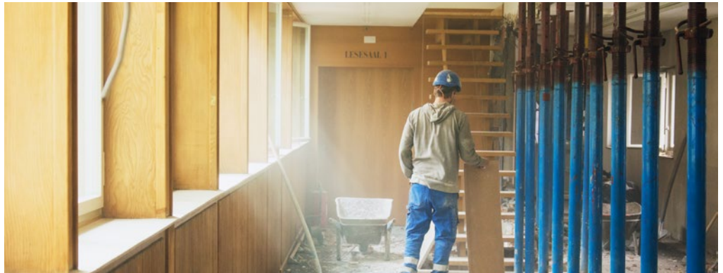
Sanierung der Zentral- und Hochschulbibliothek
