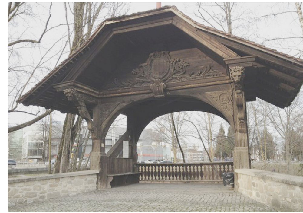
Die Holzbrücke am Seetalplatz
