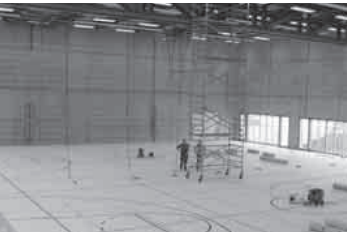
Die neue Turnhalle der KMS.
