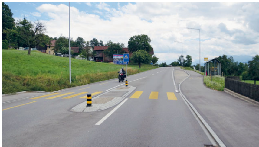
Foto 4: K17, Abschnitt Rütistrasse, Büron
