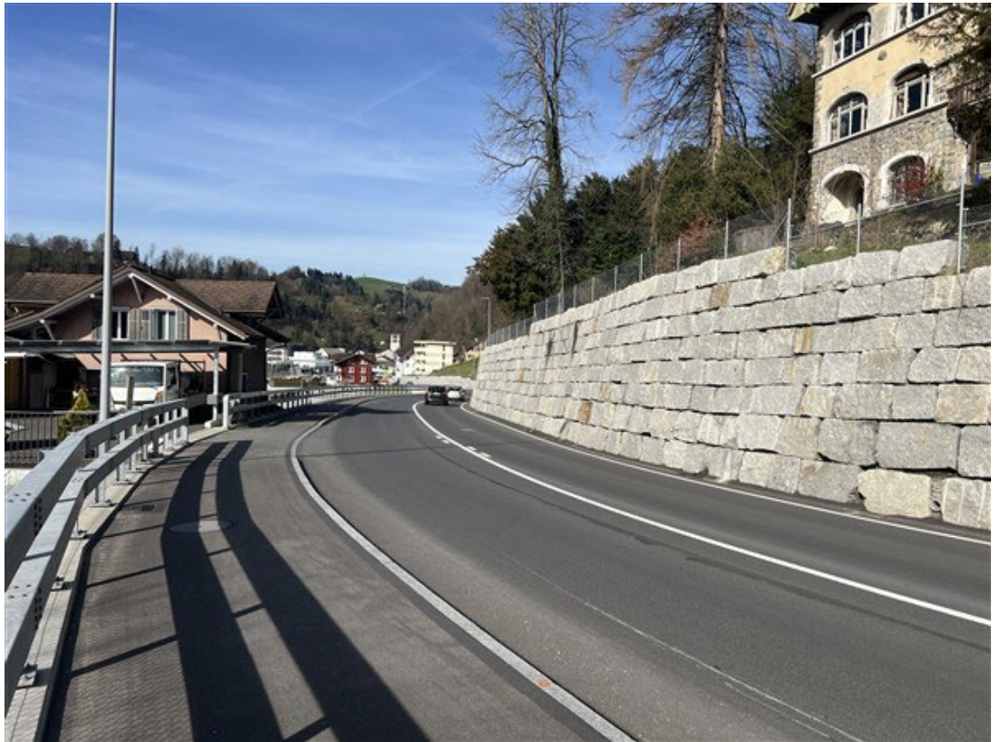
Standort 2: Geistlichkurve, Stützmauern Sonnenbüel und Hackenrüti
