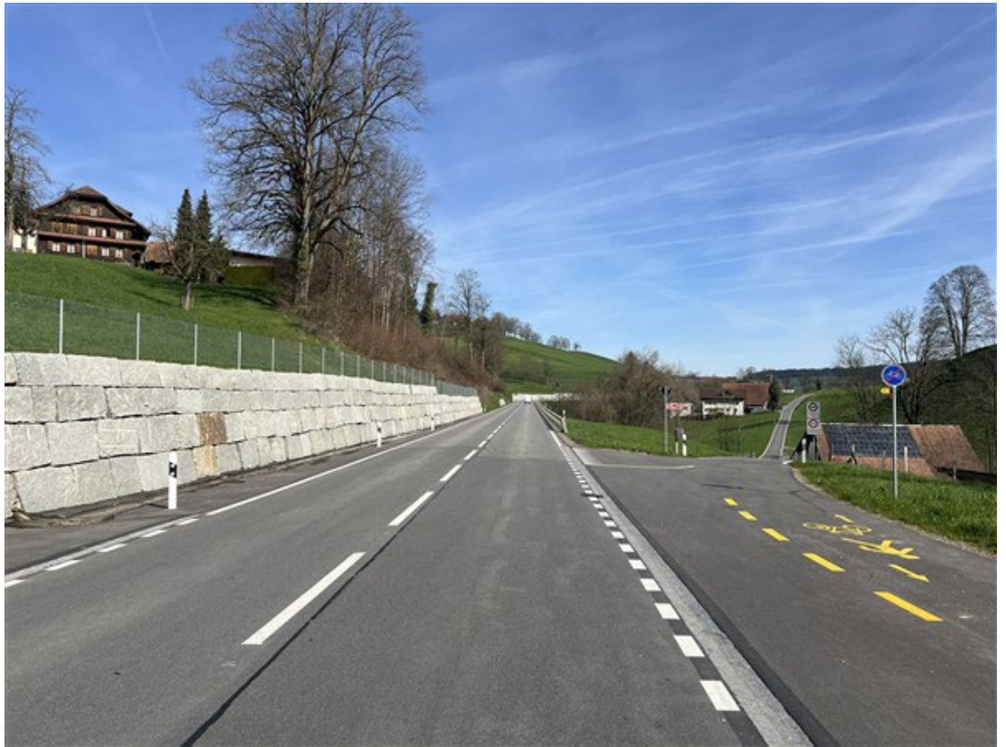
Standort 5: Bielmüli mit Stützmauern Biel und Chriesbaumen im Hintergrund
