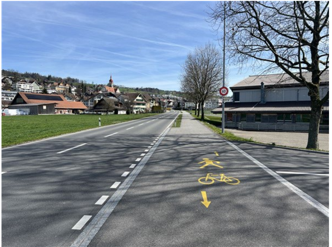
Standort 9: Situation auf der Höhe der Mehrzweckhalle Ruswil
