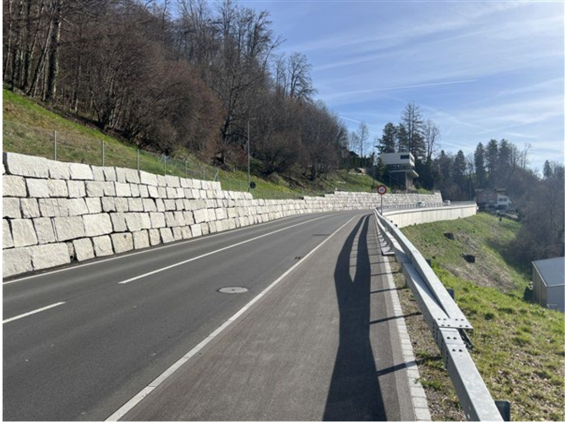
Standort 1: Stützmauer Sonnebüel links und Stützmauer Hackenrüti rechts
