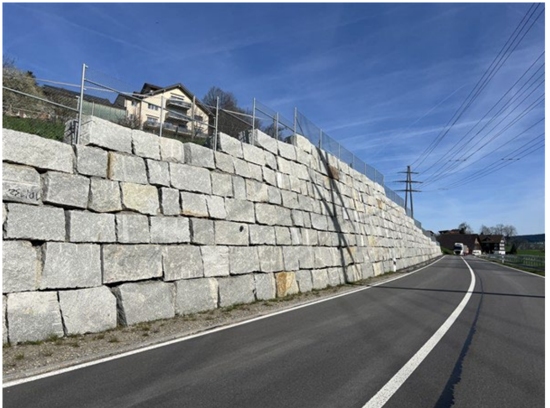
Standort 4: Stützmauer Horüti
