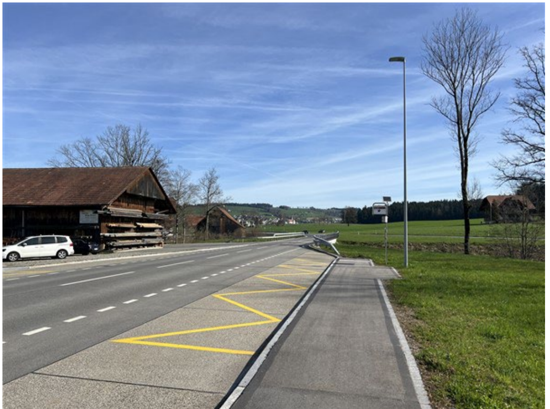
Standort 6: Haltebuchten Altwis mit neuer Linienführung und Brücke Sagemüli im Hintergrund
