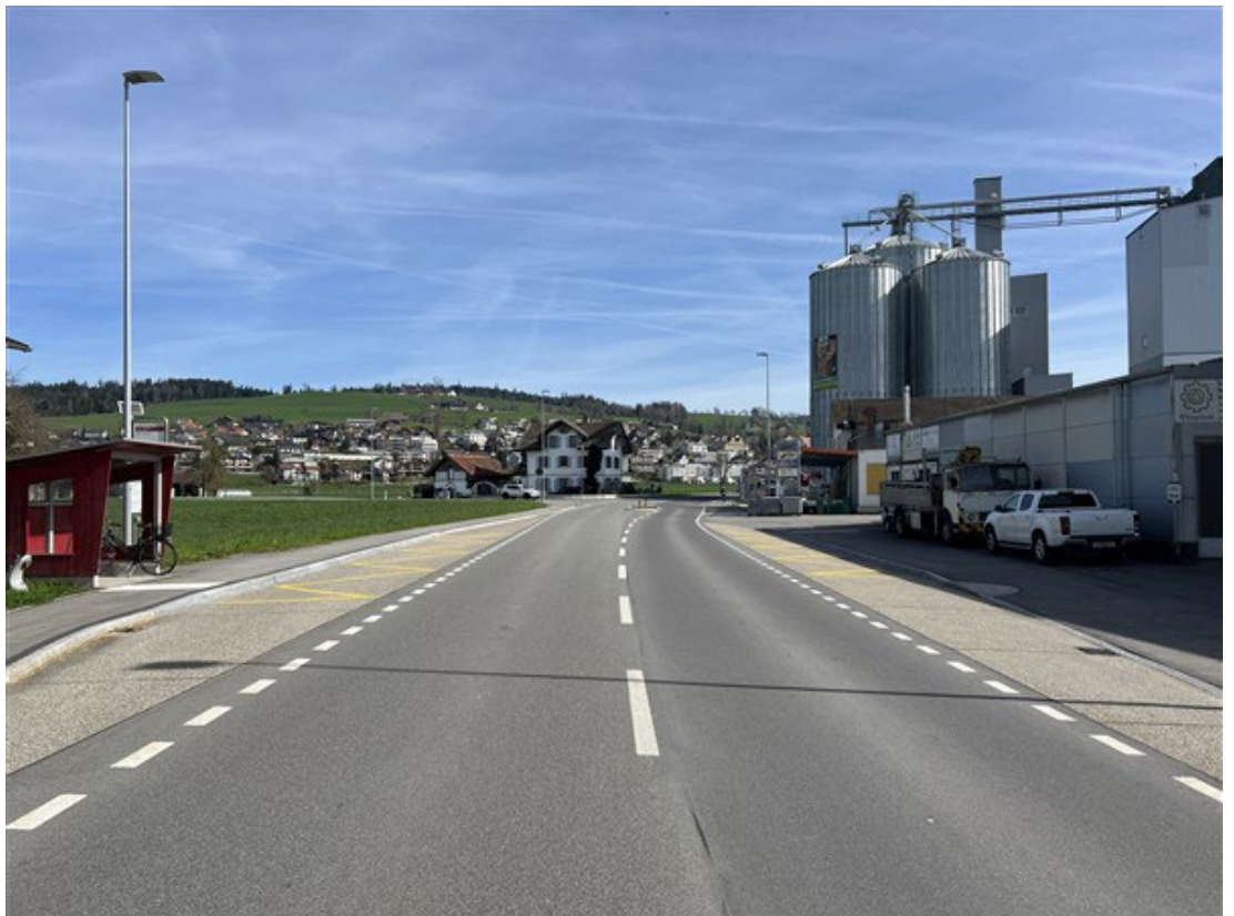
Standort 8: Haltebuchten Freieck und Abzweigung Lehnstrasse im Hintergrund
