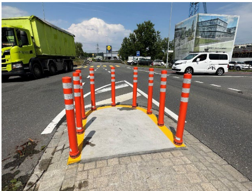
Abb. 5: Schutzinsel für Verkehrslotse beim Knoten K 65c/Hauptstrasse (Kanalbrücke)
