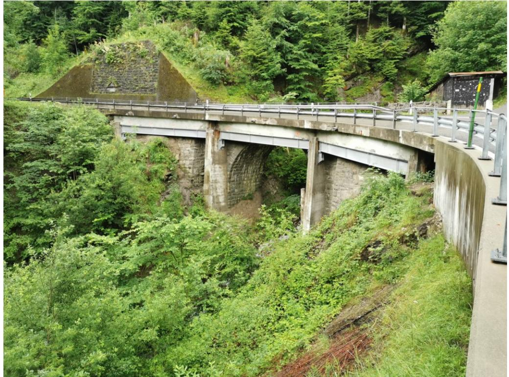
Abb. 2: Bogenbrücke Oberlammberg mit der verstärkten Strassenauskragung
