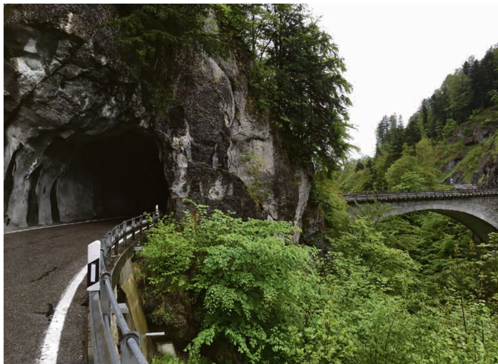
Chlusstaldentunnel und Chlusbodenbrücke eingangs der Lammschlucht
