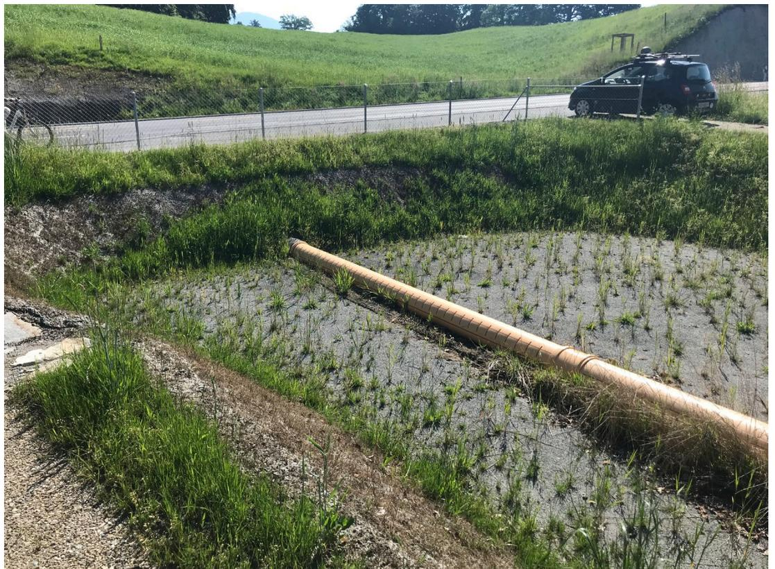
*Foto 4: Strassenabwasserbehandlungsanlage mit natürlichem Filterbecken*
