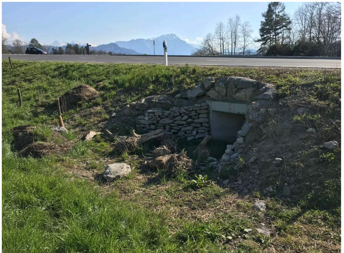
*Foto 8: Kleintierdurchlass im Bereich der Wartenfluhkurve*
