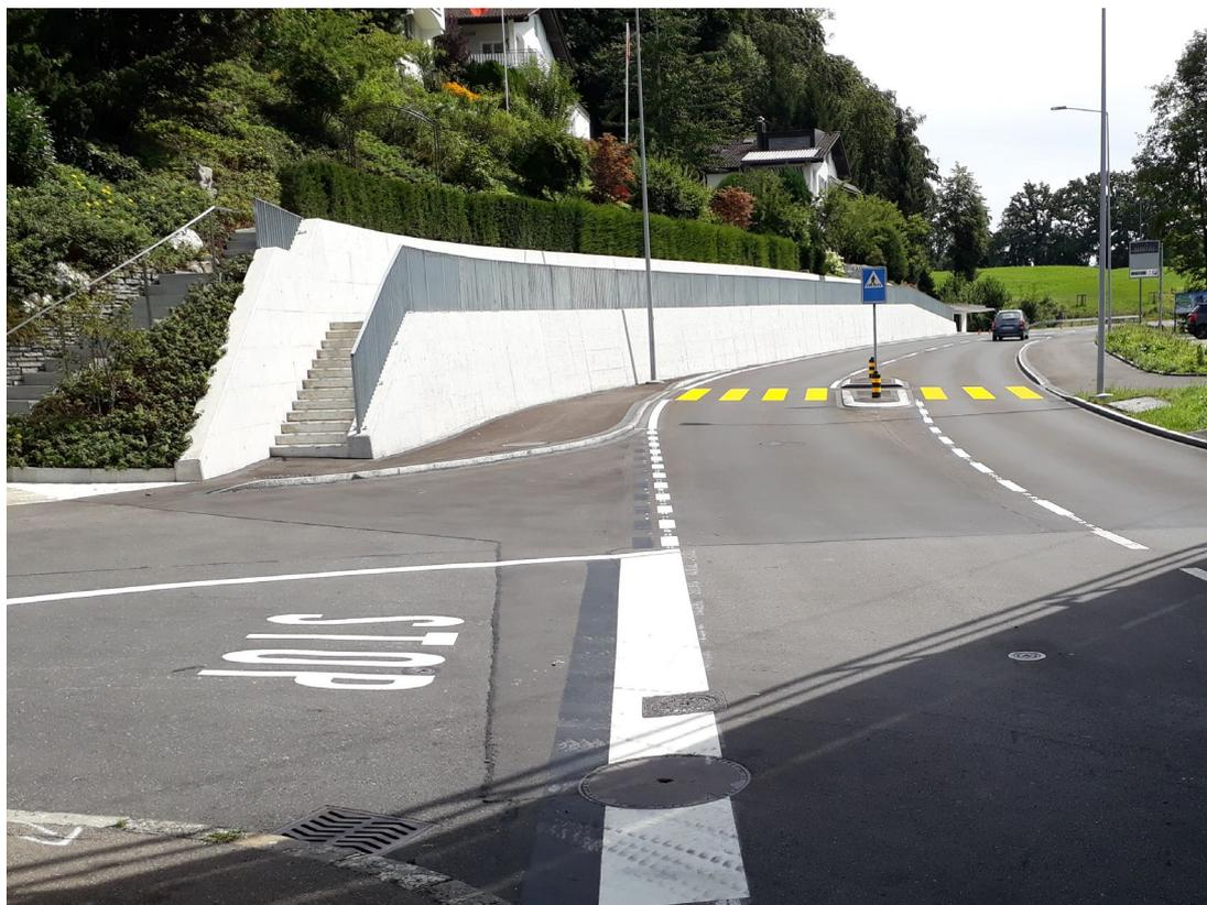
*Foto 1: Neue Stützmauer Rebstock mit oberliegendem Fussweg*
