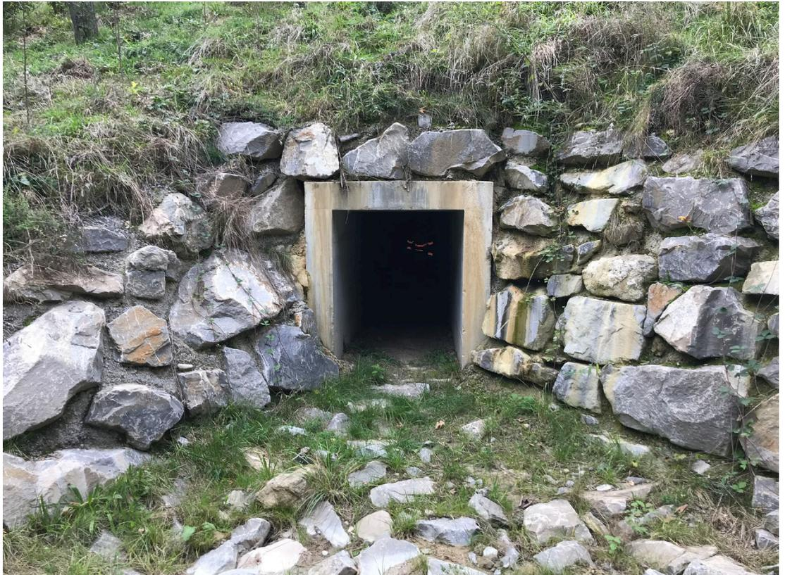
*Foto 6: Begehbarer Kleintierdurchlass im Bereich des Oberrebstockbachs*
