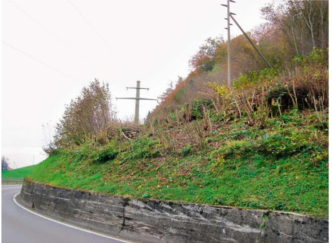
*Foto 5: K4, Abschnitt Ränggloch–Horüti, Schleifspuren an bestehenden Kunstbauten infolge ungenügender Strassenbreite*
