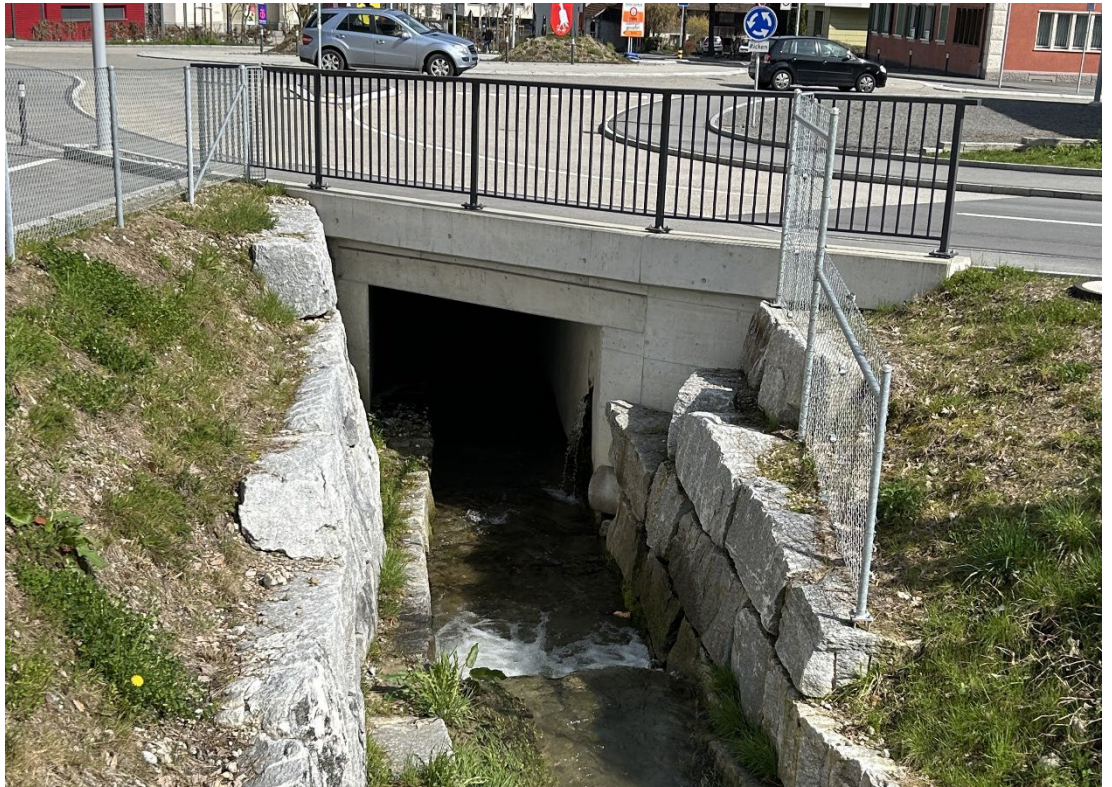
Foto 5: Einlauf Rickenbach in den neuen Bachdurchlass
