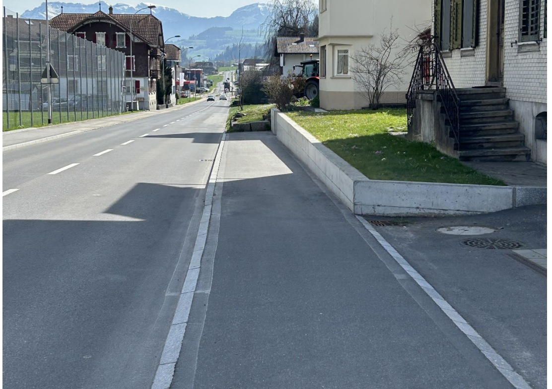
Foto 7: Verlängerung des Trottoirs in Richtung Wolhusen
