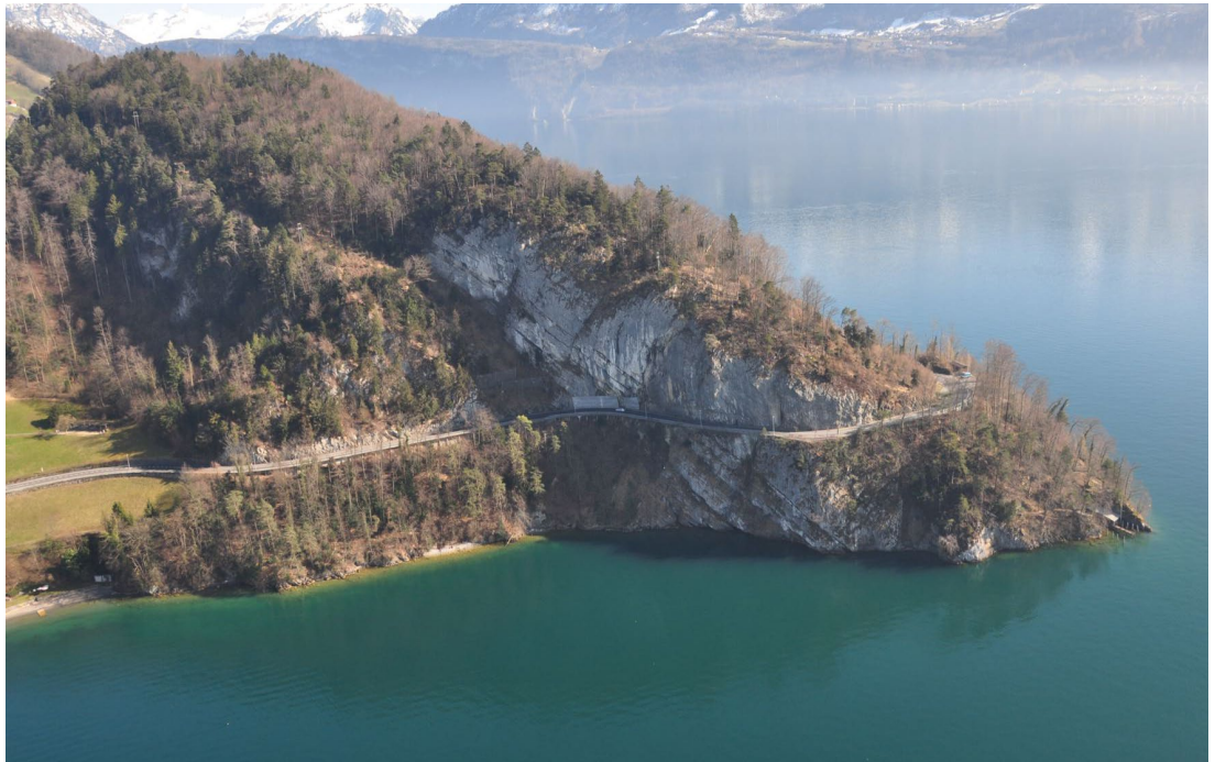
Abb. 3: Blick auf den Abschnitt Bürglen – Kantonsgrenze Schwyz
