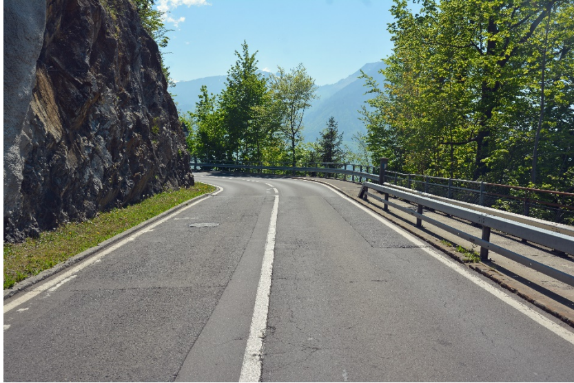
Foto 7: Seestrasse auf der Höhe der Kantonsgrenze Luzern-Schwyz
