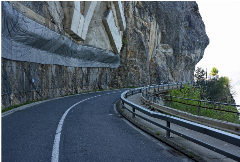
Foto 4: Rechtskurve unter dem sanierten Felsen
