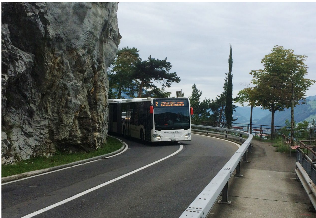
Abb. 2: Kantonsstrasse im Bereich «Ober Nas»
