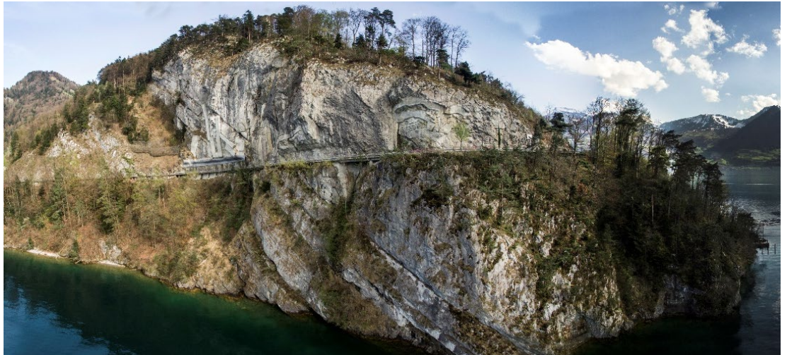
Abb. 5: Ist-Situation im Bereich «Ober Nas»
