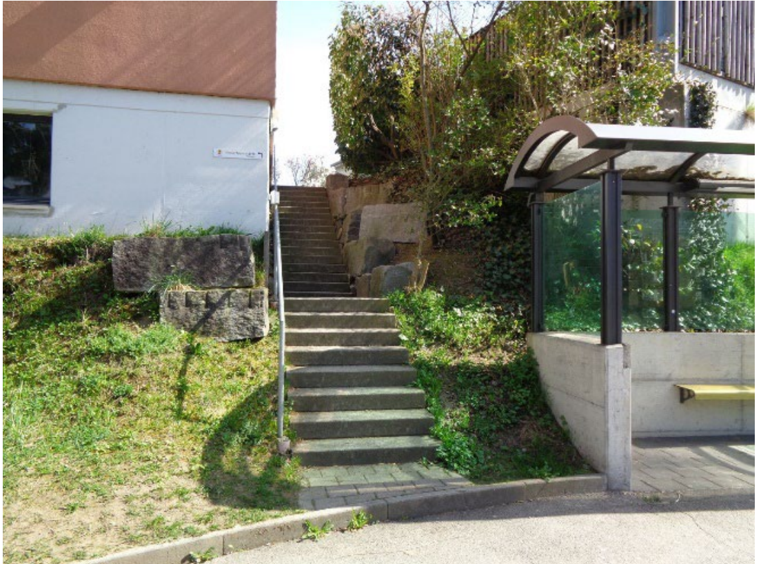
Standort 3: Treppe bei der Haltestelle Bösfeld
