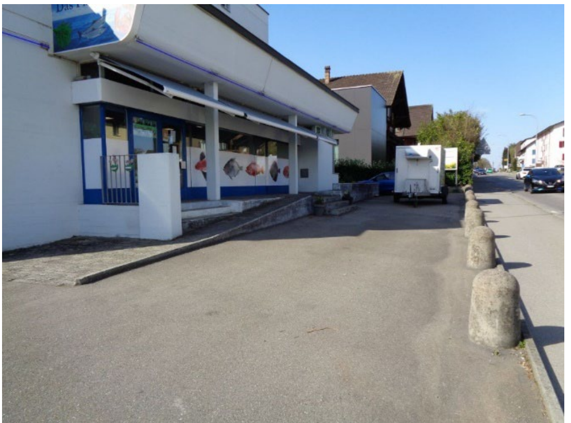
Standort 8: Vorplatz Fischhus
