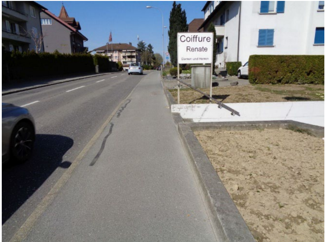
Standort 5: Eingang Coiffeur durch Treppe
