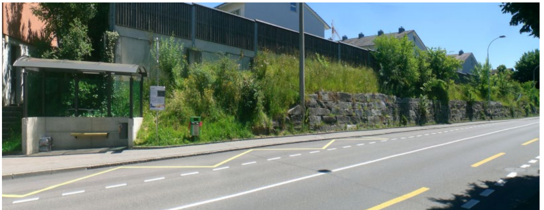
Standort 4: Haltestelle Bösfeld mit Stützmauer und Lärmschutzwand
