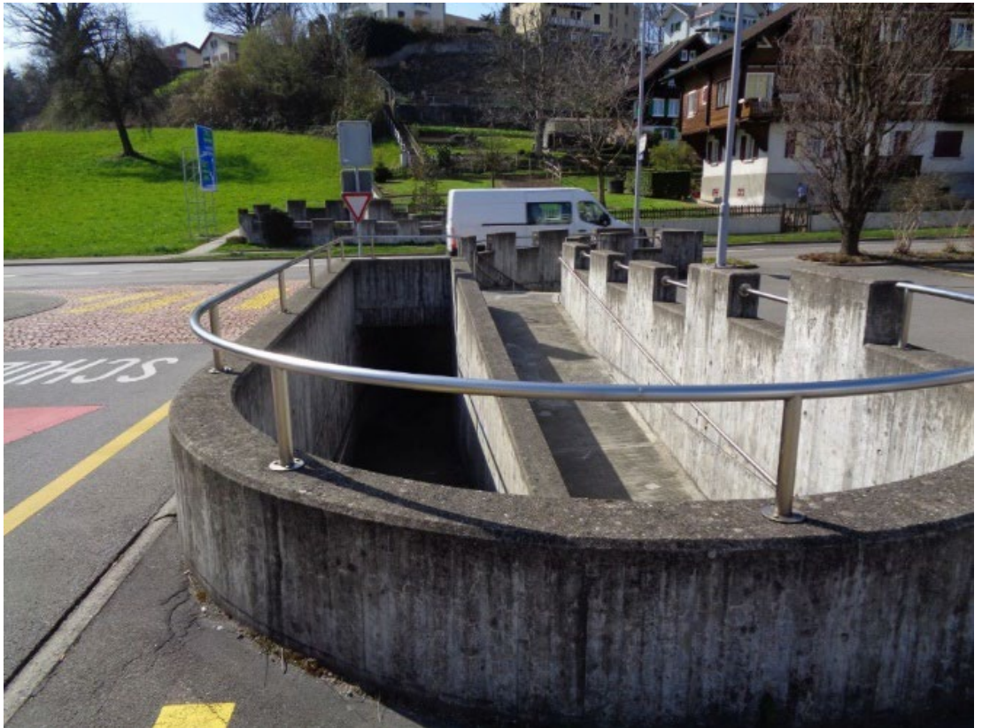
Standort 7: Unterführung bei Waldeggstrasse
