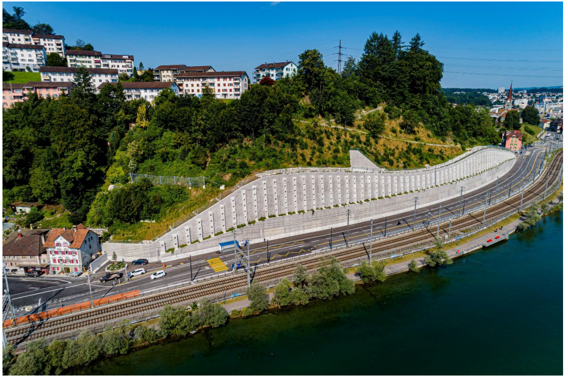
Foto 11: Drohnenaufnahme: Ansicht Stützmauer Reussthal aus Südosten
