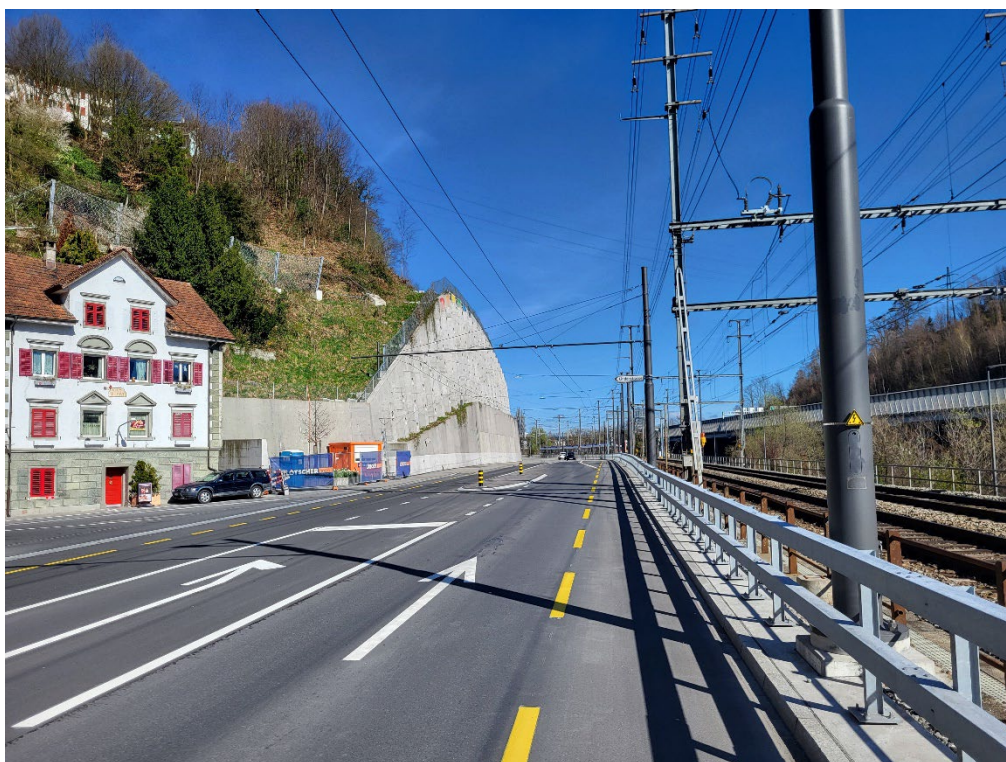
Foto 1: Ansicht neue Stützmauer Reussthal ab Einmündung Lindenstrasse in Blickrichtung Seetalplatz. Neues Murgangnetz oberhalb Gebäude (links im Bild) und neue Leitschranke entlang der SBB (rechts im Bild).
