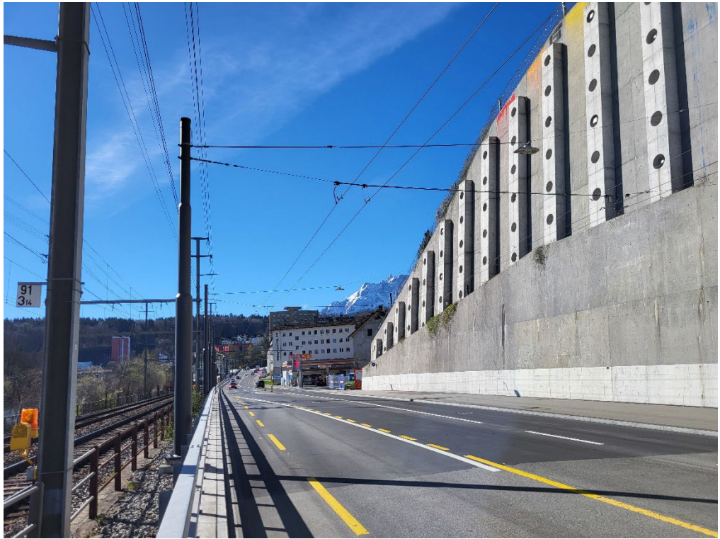
Foto 5: Standort Hauptstrasse mit Ansicht Mauerende Seite Luzern. Neue Masten (links im Bild) inklusive Abspannungen für VBL-Fahrleitungen und Tragseile der neuen Strassenbeleuchtung.
