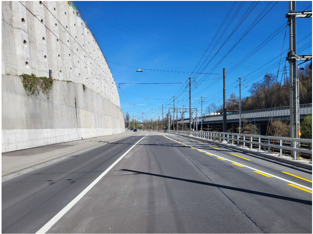
Foto 3: Standort Hauptstrasse bei Mauerende Seite Luzern in Blickrichtung Seetalplatz. Neue zweistufige Stützmauer mit begrünter Berme.
