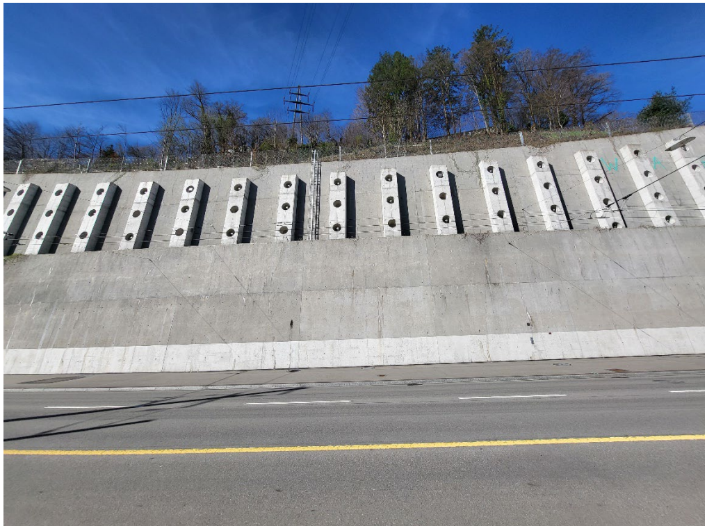
Foto 6: Frontalansicht neue Stützmauer mit neuem Steinschlagnetz auf der Mauerkrone. Die Leiter in der Bildmitte dient als Zwischenzugang für Unterhaltsarbeiten.
