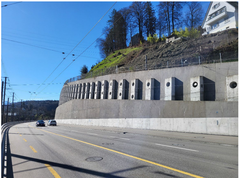
Foto 8: Ansicht Mauerende in Blickrichtung Luzern
