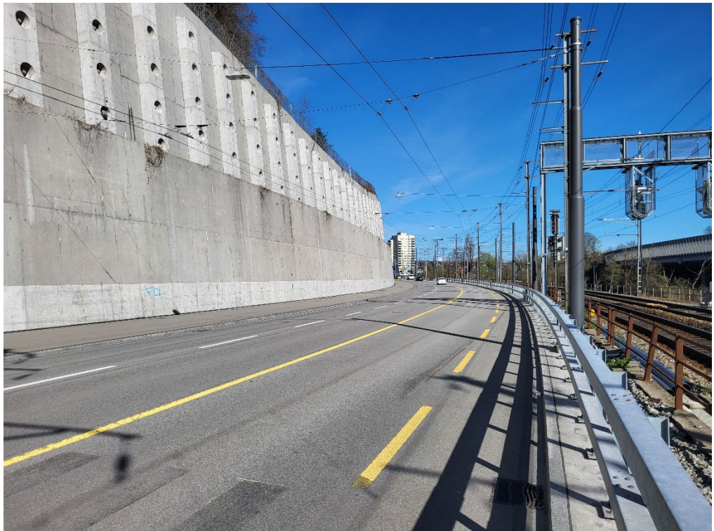
Foto 4: Standort Hauptstrasse in Blickrichtung Seetalplatz. Vertikale Rippen mit den runden Löchern für die Rückverankerung der Stützmauer.
