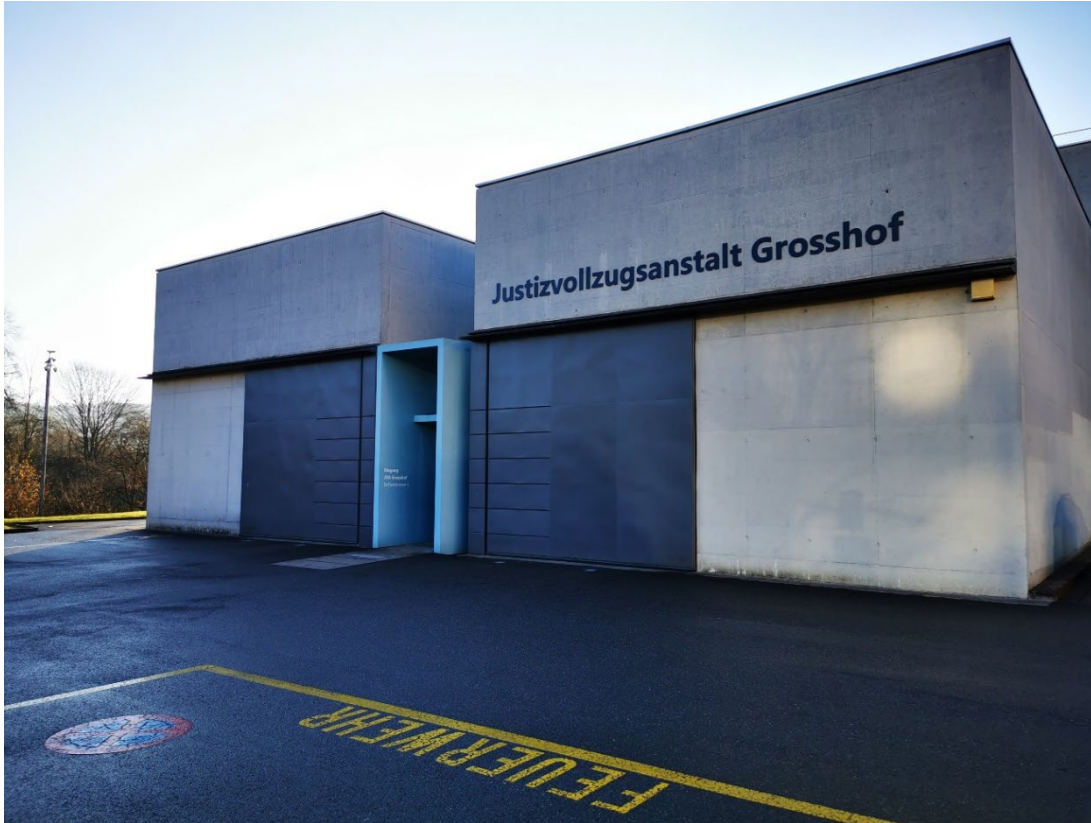
Abb. 6: Eingang Justizvollzugsanstalt Grosshof
