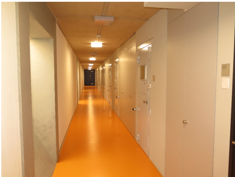
Korridor neuer Zellentrakt
