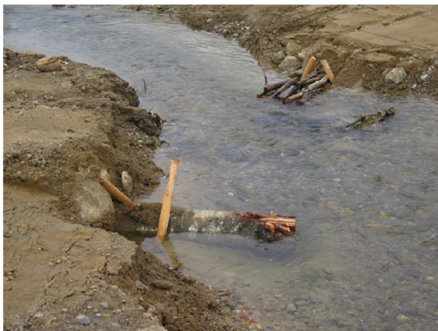
Abb. 3: Bühnen aus Baumstämmen und Faschinen
