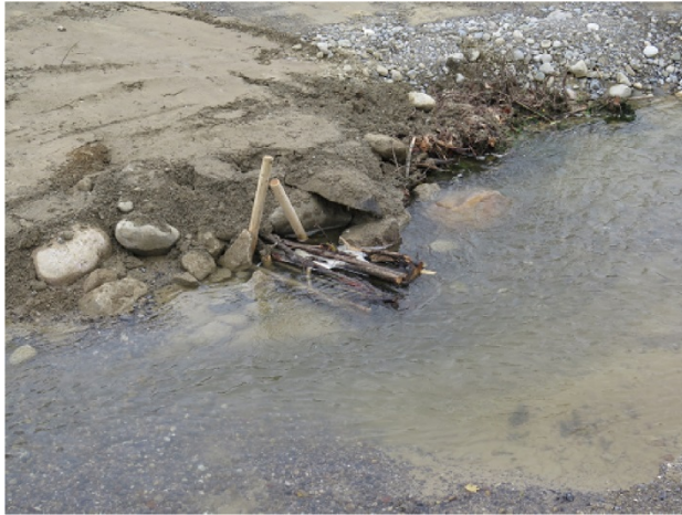
Abb. 1: Faschinen als Strukturierungselement
