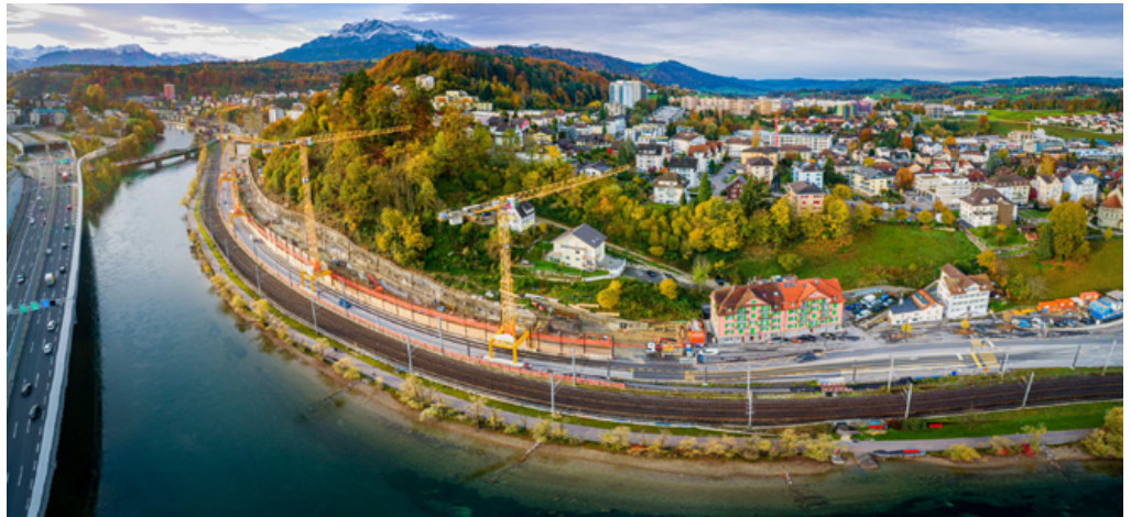
Durch die rückversetzte Reussthalmauer entsteht Platz für eine neue Busspur und einen Rad-/Gehweg. (Quelle Bild: Emch+Berger WSB AG)
