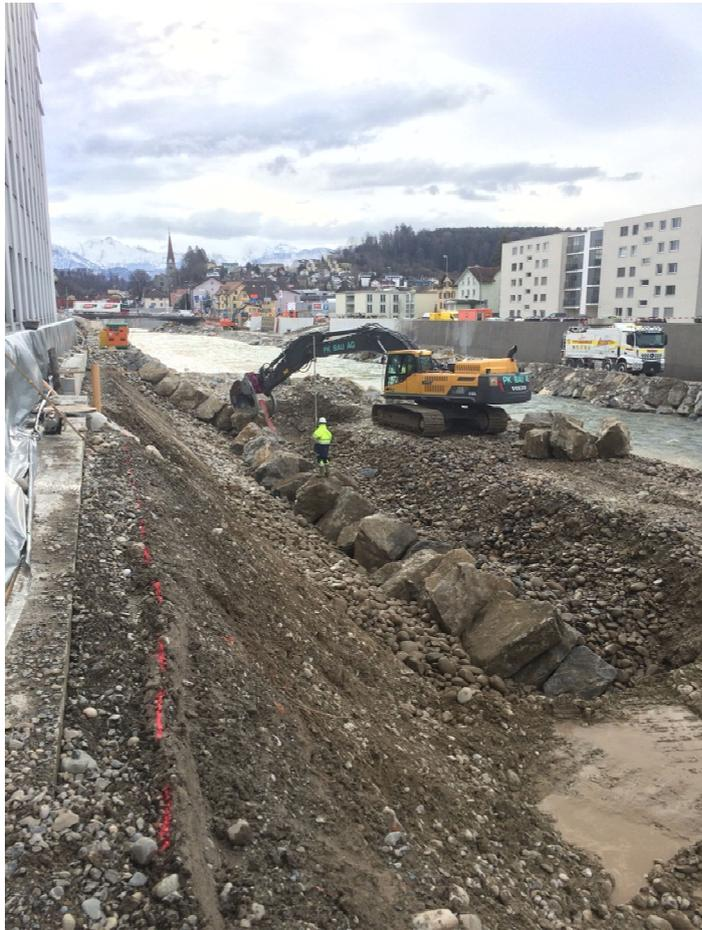
*Bild 3: linksufriger Blocksatz mit Filterschicht*
