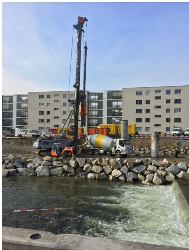
*Bild 2: Grossbohrgerät zur Erstellung von Ortbetonpfählen*
