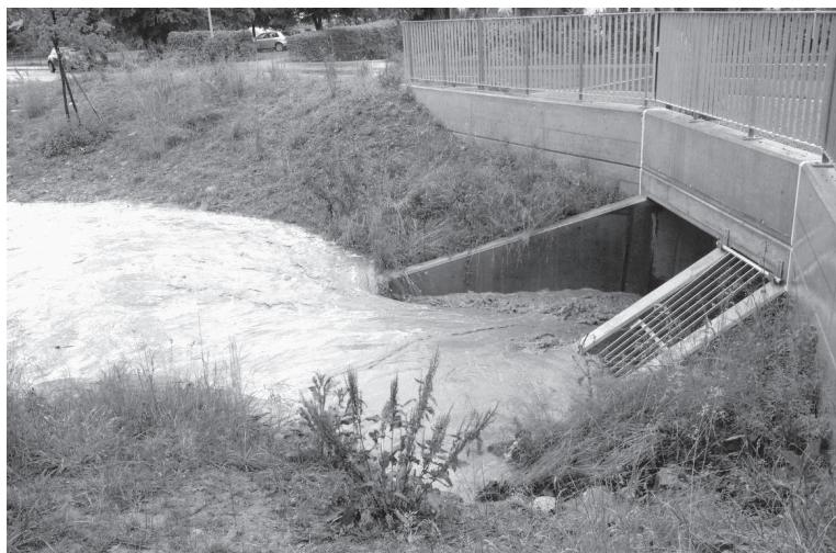
Dank der neuen Durchlasskonstruktion konnte die Sohle höher gelegt werden. Das hatte zur Folge, dass die rechtsseitige Ufermauer in ihrer Höhe um zwei Steinlagen reduziert und die linke Seite naturnah gestaltet werden konnte.
