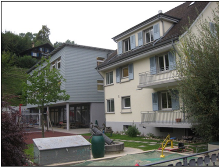
Schulanlage Am Schützenrain, Willisau
