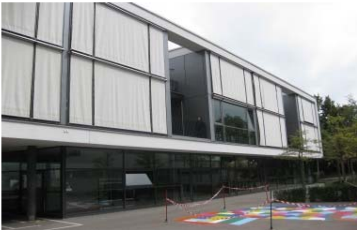
Schulanlage Kottenmatt, Sursee
