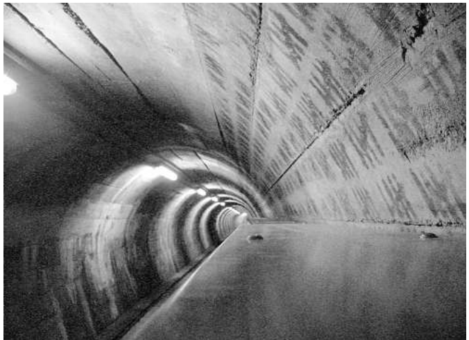
Eingangsstollen zur Zivilschutzanlage im Sonnenberg
