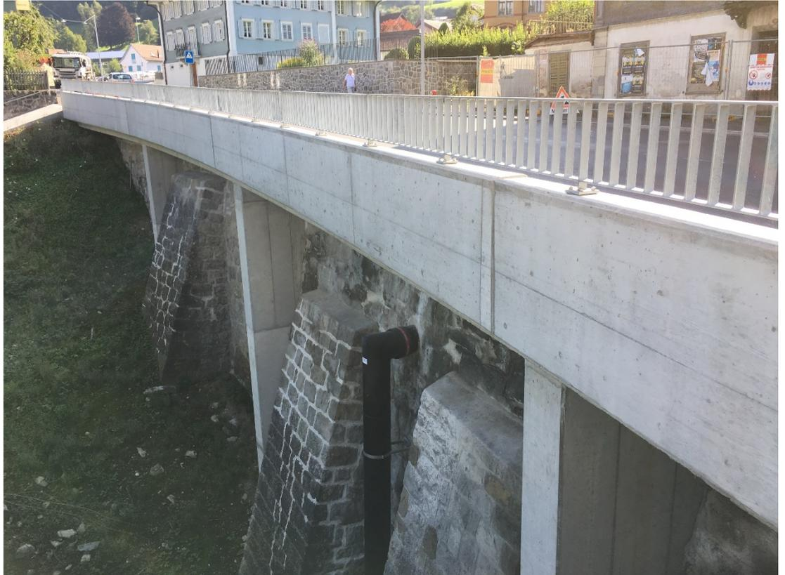
*Foto 7: Stützmauer und Gehwegauskragung Grabenloch*
